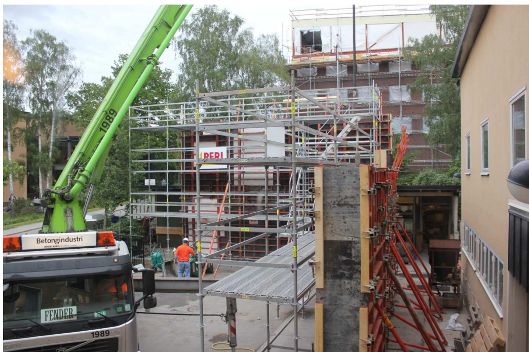
Figur 2: Foto visande försöksuppställningen samt betongpumpen. De högre (6,6 m) väggarna syns i bakgrunden och de lägre (4,2 m) i förgrunden varav den tjockaste (0,4 m) allra närmast
